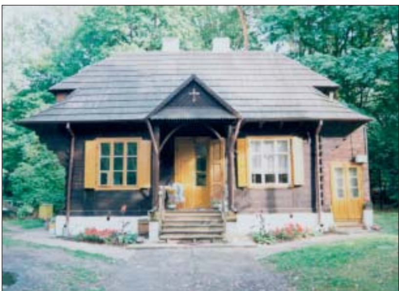
Powstałe w latach 20-tych XX w. Osiedle w Zalesiu Dolnym, podzielone na duże, leśne parcele jest przykładem założeń urbanistycznych tzw. miast-ogrodów
