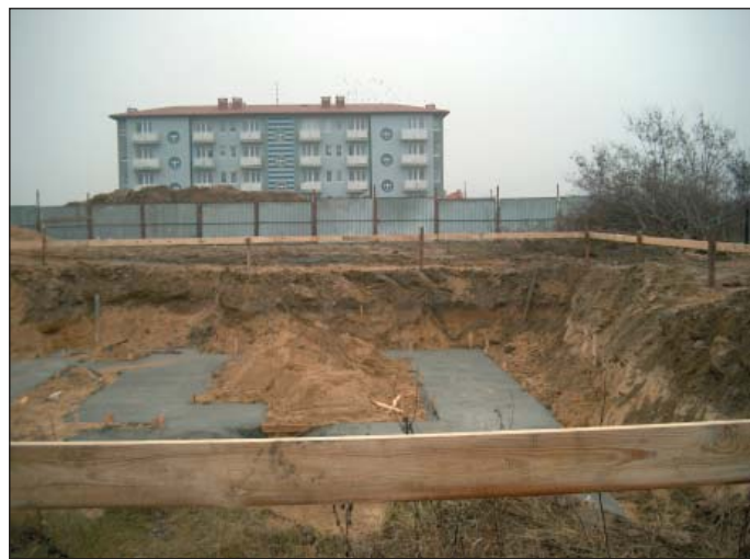
Przy ul. Urbanistów w listopadzie br. ruszyła budowa kolejnego gminnego budynku z mieszkaniami socjalnymi
