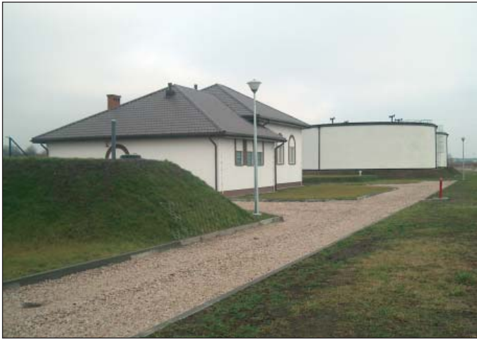
W listopadzie zakończone zostały prace przy rozbudowie Stacji Uzdatniania Wody w Siedliskach
