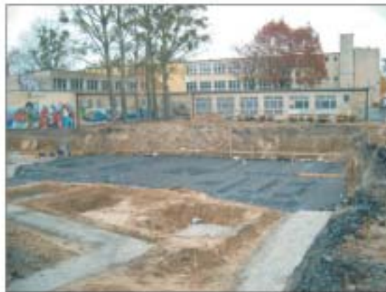
Razem z budową SP nr 5 w Piasecznie wraz z budową sali sportowej
