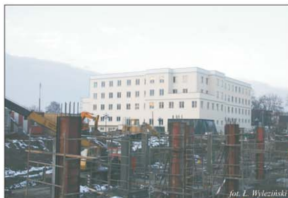
Powstający gmach sądu i prokuratury, w tle nowa komenda powiatowa policji
