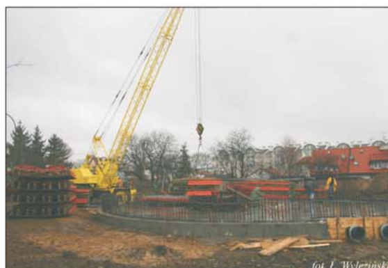
Stacja Uzdatniania Wody przy ul. Żeromskiego
