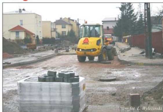
Budowa ul. Chełmońskiego
