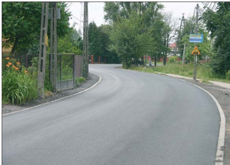
Nowa nawierzchnia na ul. Łabędziej
