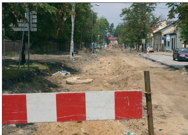
Tuż po zakończeniu prac na ul. Kościuszki rozpocznie się modernizacja ul. Jana Pawła II
