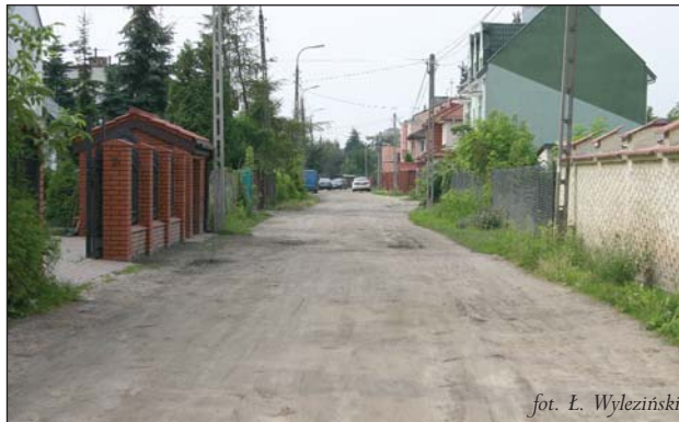
Gruntowa ulica Niecała zyska nową nawierzchnię
