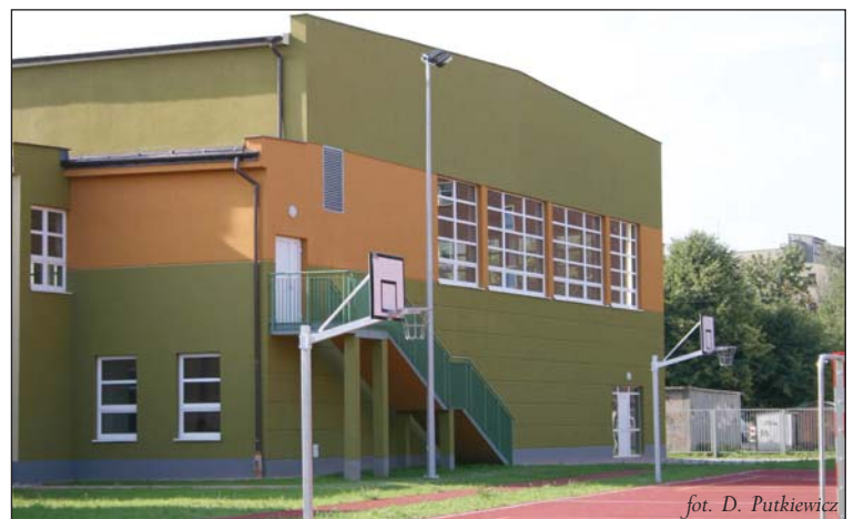
Oddana do użytku w tym roku nowa część szkoły oraz hala sportowa przy SP nr 5 w Piasecznie
