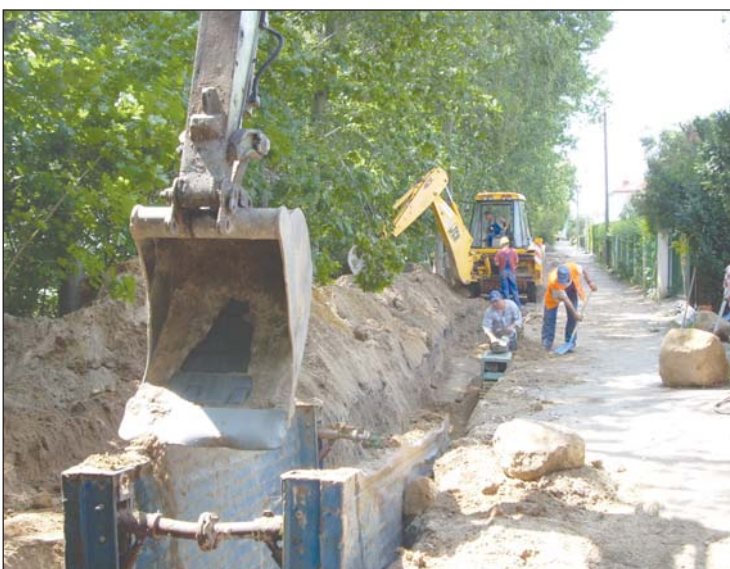
Budowa kanalizacji sanitarnej w Żabieńcu i Siedliskach
