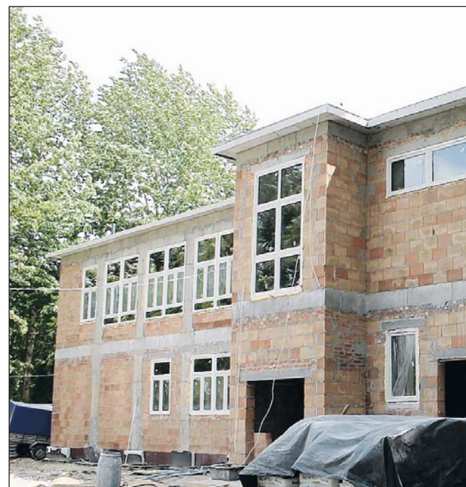
Budowa Przedszkola nr 6 i Filii Biblioteki Publicznej w Głoskowie
