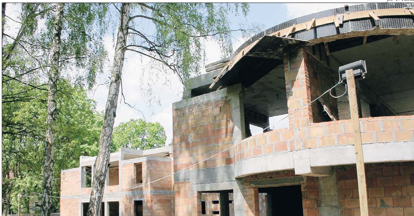
Budowa nowego przedszkola w Zalesiu Dolnym
