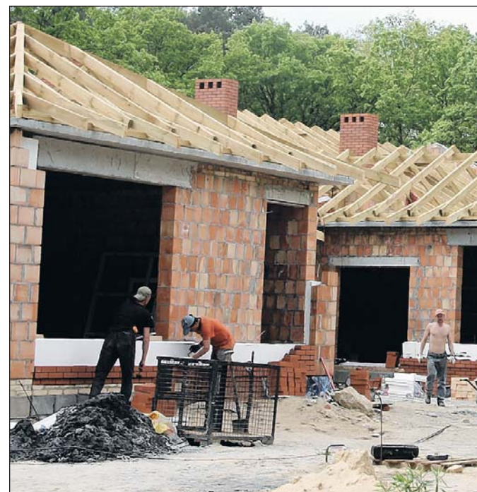
Prace przy budowie przedszkola w Zalesiu Górnym
