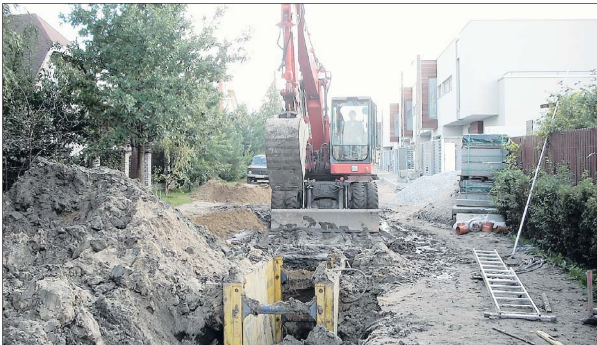
W ramach projektu wybudowanych zostanie ponad 130 km sieci kanalizacyjnej
