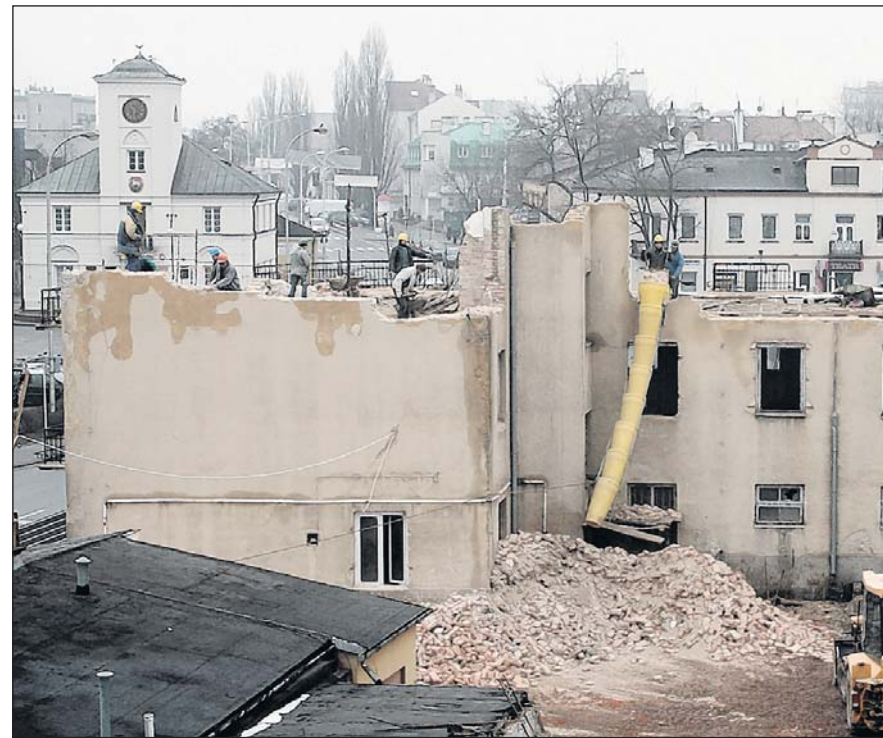
Modernizacja budynku po byłej Komendzie Policji na potrzeby Ośrodka Kultury
