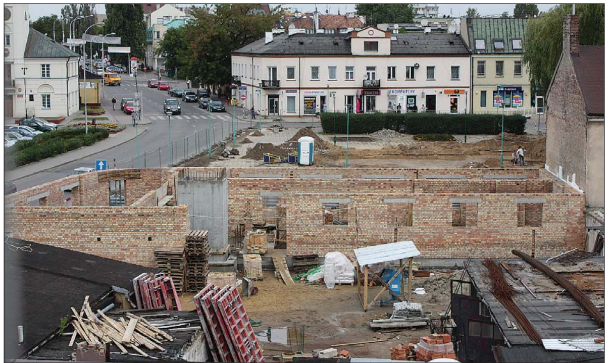
Budowa nowej siedziby Ośrodka Kultury
