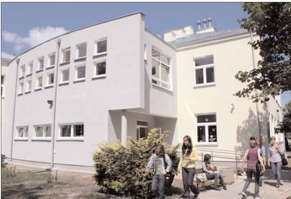
Fragm. rozbudowanej szkoły w Chylicach
