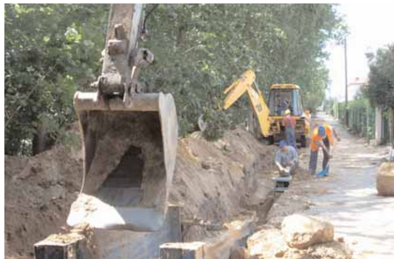
W ramach programu gospodarki wodno-ściekowej wykonano 130 km kanalizacji podłączając do systemu 3,5 tys. posesji
