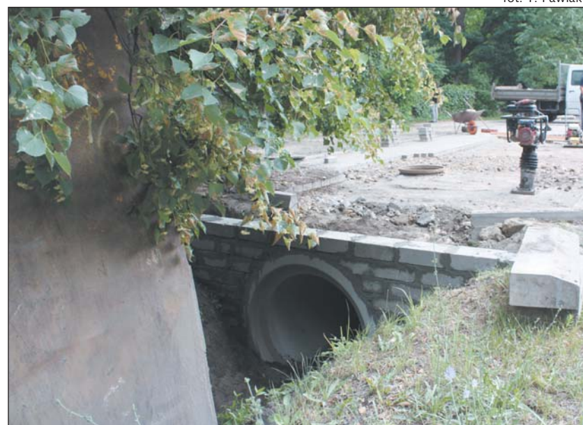
W ramach prac odwodnieniowych wykonywane są nowe przepusty i kolektory ściekowe
