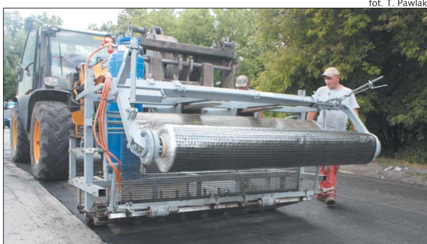
Układanie zbrojenia z geosiatki na ul. Dworcowej
