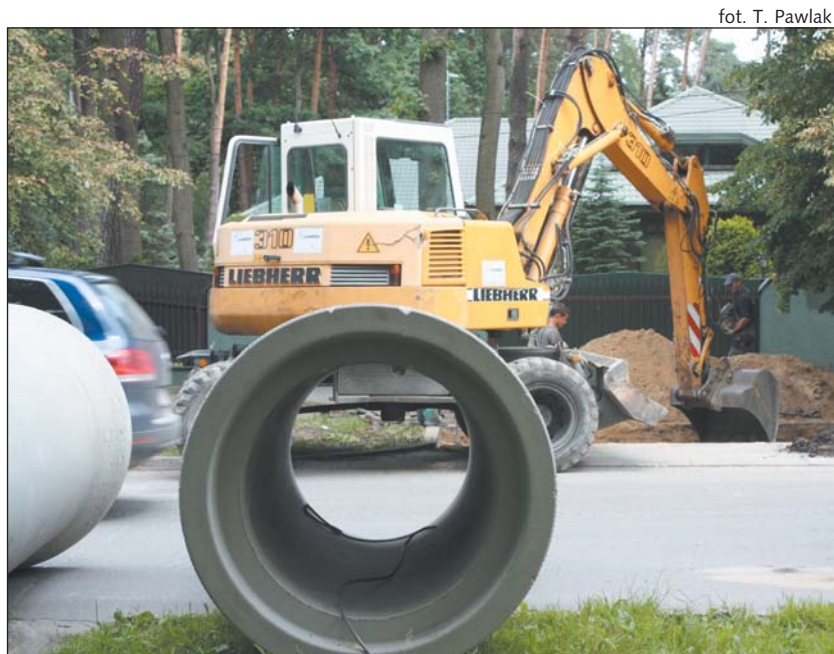
Prace odwodnieniowe na ul. 3-go Maja w Zalesiu Dolnym
