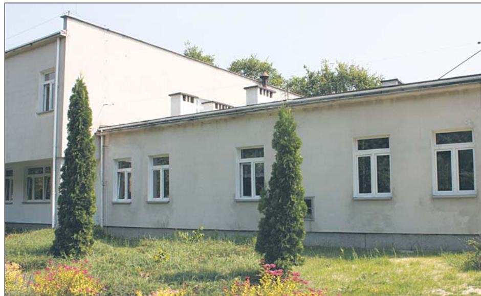
Nad istniejącym budynkiem stołówki zostanie dobudowane nowe piętro, które będzie przeznaczone dla klas 0–3 Foto Tomasz Pawlak/URZĄD MIASTA
