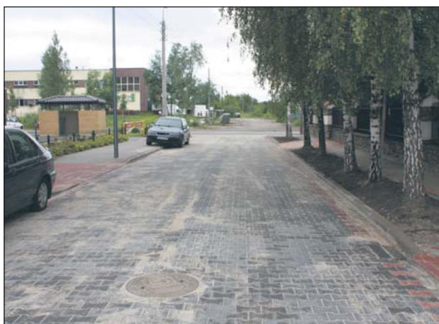
Przebudowane ulice Saperów i Lotników odchodzące od ulicy Dworcowej Foto Tomasz Pawlak/URZĄD MIASTA
