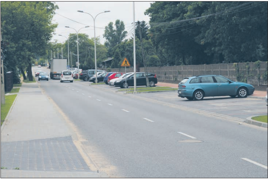
Na pierwszym z przebudowywanych odcinków ul. Julianowskiej powstało 114 nowych miejsc parkingowych Foto Krzysztof Kasprzycki/URZĄD MIASTA
