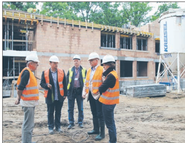
Wizyta na placu budowy szkoły w Zalesiu Górnym
