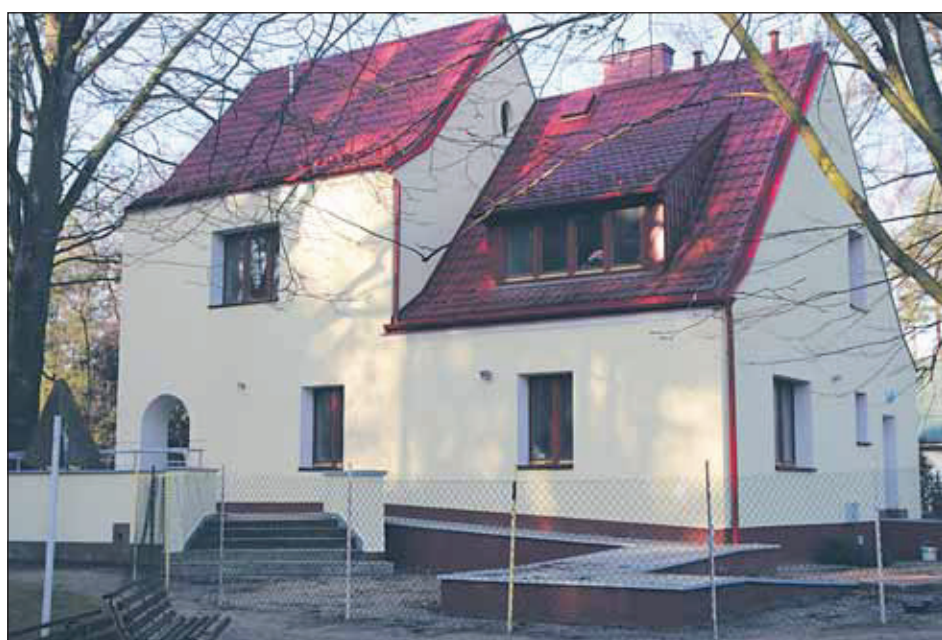
Wyremontowana willa przy ul. Ks. Józefa przyjmie nowych przedszkolaków w styczniu 2015 r.
