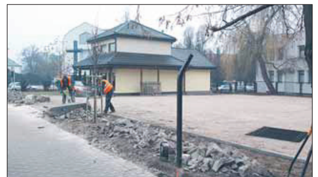
Na miejscu wyburzonego budynku przygotowywane są miejsca parkingowe. Foto Łukasz Wyleziński/URZĄD MIASTA
