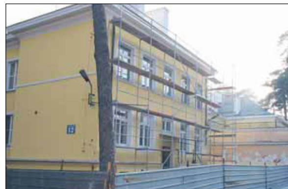
W Szkole Podstawowej im. Ewy Krauze w Zalesiu Dolnym na ukończeniu jest wymiana całego pokrycia dachu.
