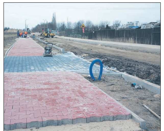
Dobiegają końca prace brukarskie na pierwszym etapie przebudowy ul. Mleczarskiej. Foto Łukasz Wyleziński/UMiG
