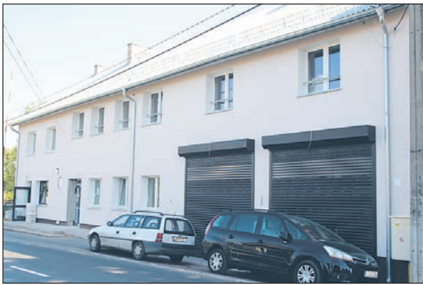
W rozbudowanym budynku OSP oprócz Straży mieści się też biblioteka i sklep
