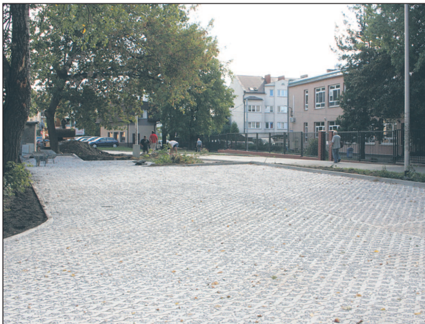
Nowy parking przy ul. Fabrycznej w Piasecznie
