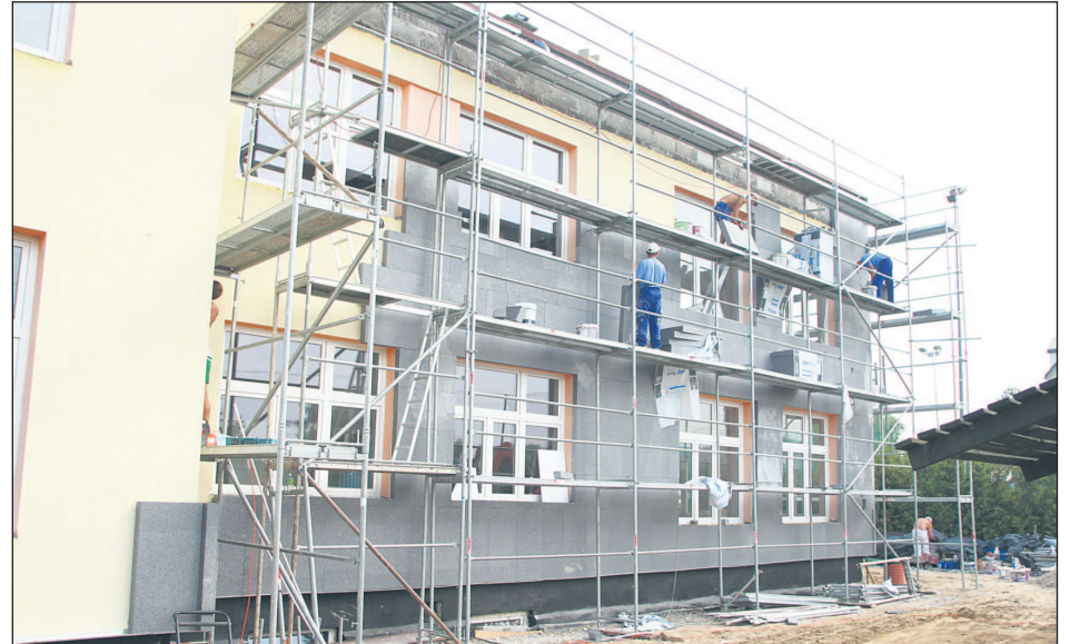
Prace przy elewacji budynku Przedszkola nr 11 przy ul. Nefrytowej w Piasecznie
