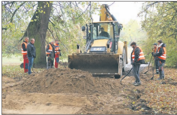
Trwają prace przy budowie nowych alejek w Parku Miejskim Foto Łukasz Wyleziński/URZĄD MIASTA
