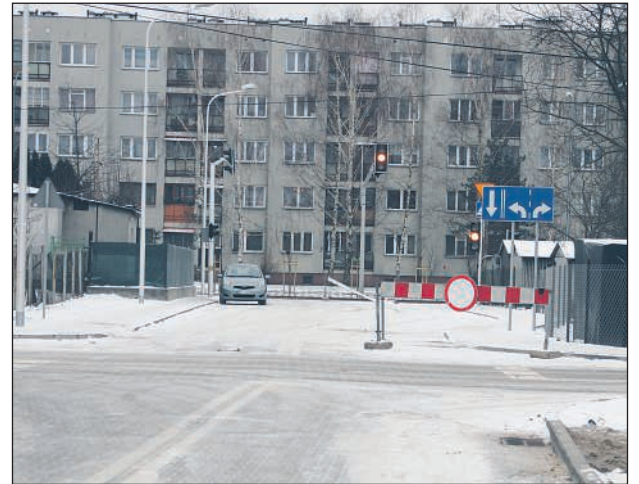
Nowy studziszestometrowy odcinek ul. Bocianej zostanie oddany do ruchu pod koniec lutego Foto Tomasz Pawlak
