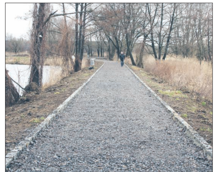
Pierwsza warstwa podłoża, na której ułożony będzie mineralny tłuczeń Foto Łukasz Wyleziński/URZĄD MIASTA
