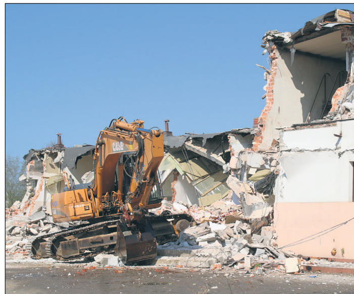
Rozbiórka dawnej piekarni na terenie inwestycji
