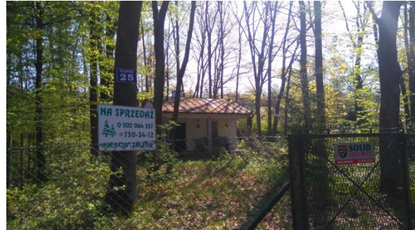
Fot. 63. Zabudowa letniskowa w pobliżu przedszkola (Fot. D. Mantey)
