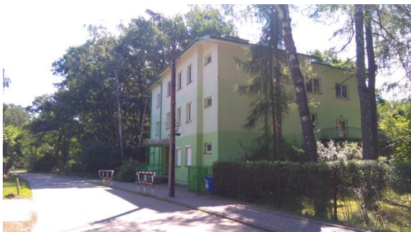
Fot. 54. Mało atrakcyjna kolorystyka elewacji budynku po byłym gimnazjum (Fot. D. Mantey)
