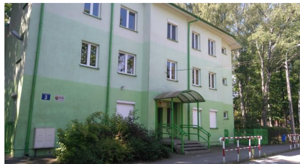
Fot. 55. Wejście do przyszłego budynku Domu Kultury (Fot. D. Mantey)
