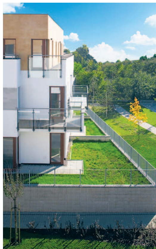
Zielone dachy na osiedlu Queens Garden powiększają udział powierzchni biologicznie czynnej. Na zdjęciu realizacja dachów nad częścią garażową - osiedle wybudowane w 2010 r.
