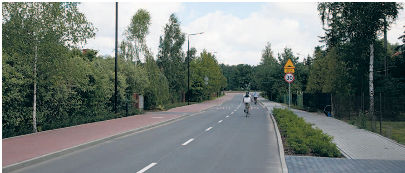
Wzdłuż nowego odcinka ul. Wilanowskiej powstała ścieżka rowerowa i chodnik
