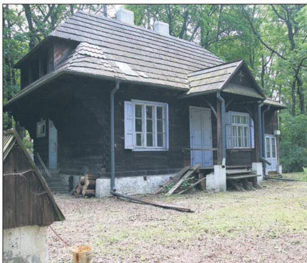
Na projekt remontu Domu „Zośki” zapisana została w budżecie gminy kwota 80 tys. zł.
