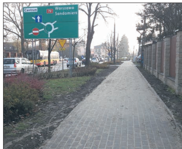
Zakończył się remont nawierzchni chodnika wzdłuż ul. Gerbera. To droga wojewódzka, jednak zlecaniodawcą robót była gmina Piaseczno
