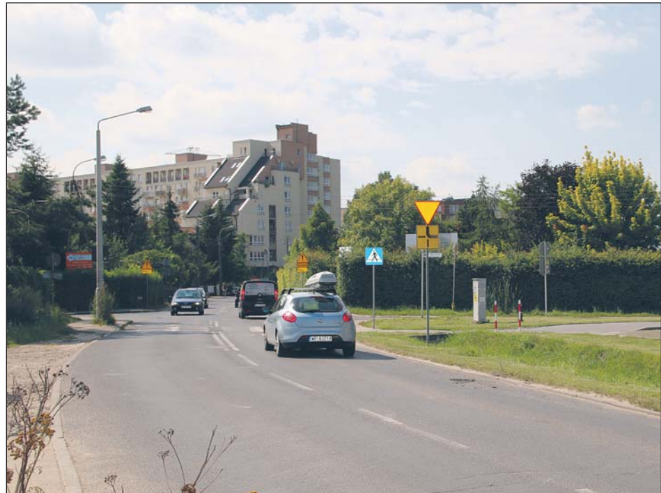
Budowa ronda turbinowego na skrzyżowaniu ul. Geodetów i Wilanowskiej będzie największą gminną inwestycją drogową w 2018 roku
