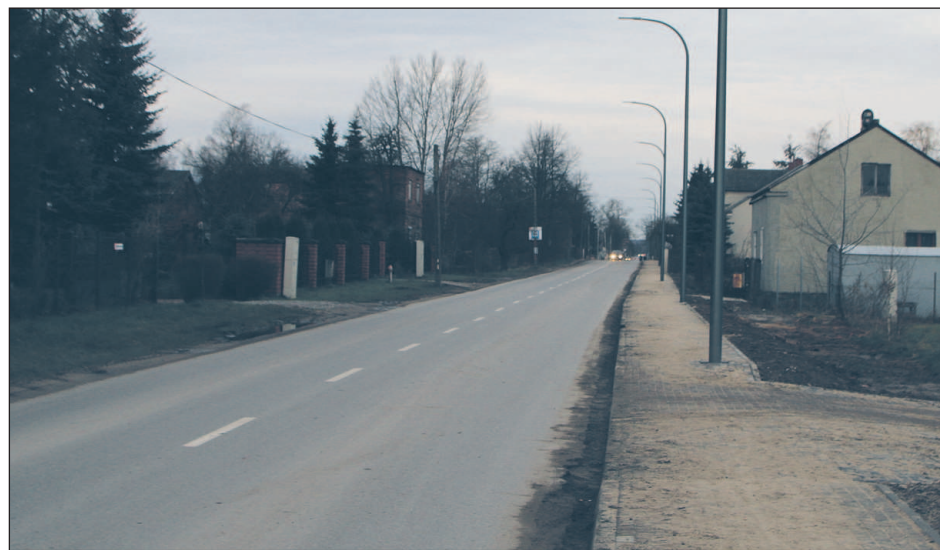
Nowy chodnik na ul. Mazowieckiej w Bobrowcu wybudowany w grudniu 2017 r.
