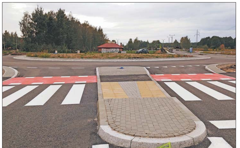
Rondo w Woli Gołkowskiej w ramach inwestycji budowy dróg dojazdowych do trasy S7
