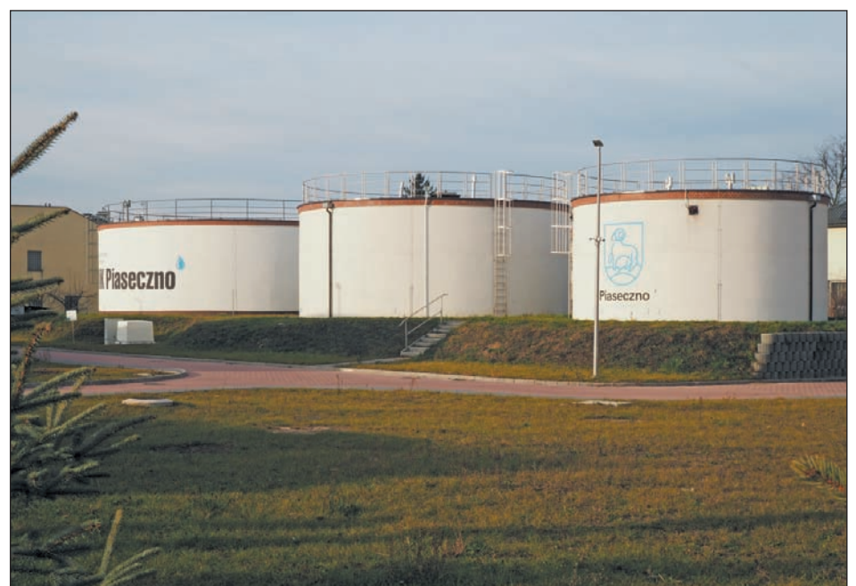
Zmodernizowana Stacja Uzdatniania Wody przy ul. Żeromskiego Foto Anna Grzejszczyk/UMiG
