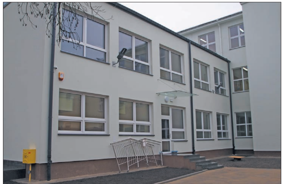
Rozbudowa Szkoły Podstawowej nr 3 jest już na ukończeniu
