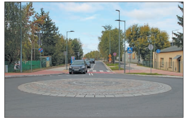
Przebudowana ulica Geodetów wraz z rondem na Julianowskiej Foto Lukasz Wyleziński/URZĄD MIASTA
