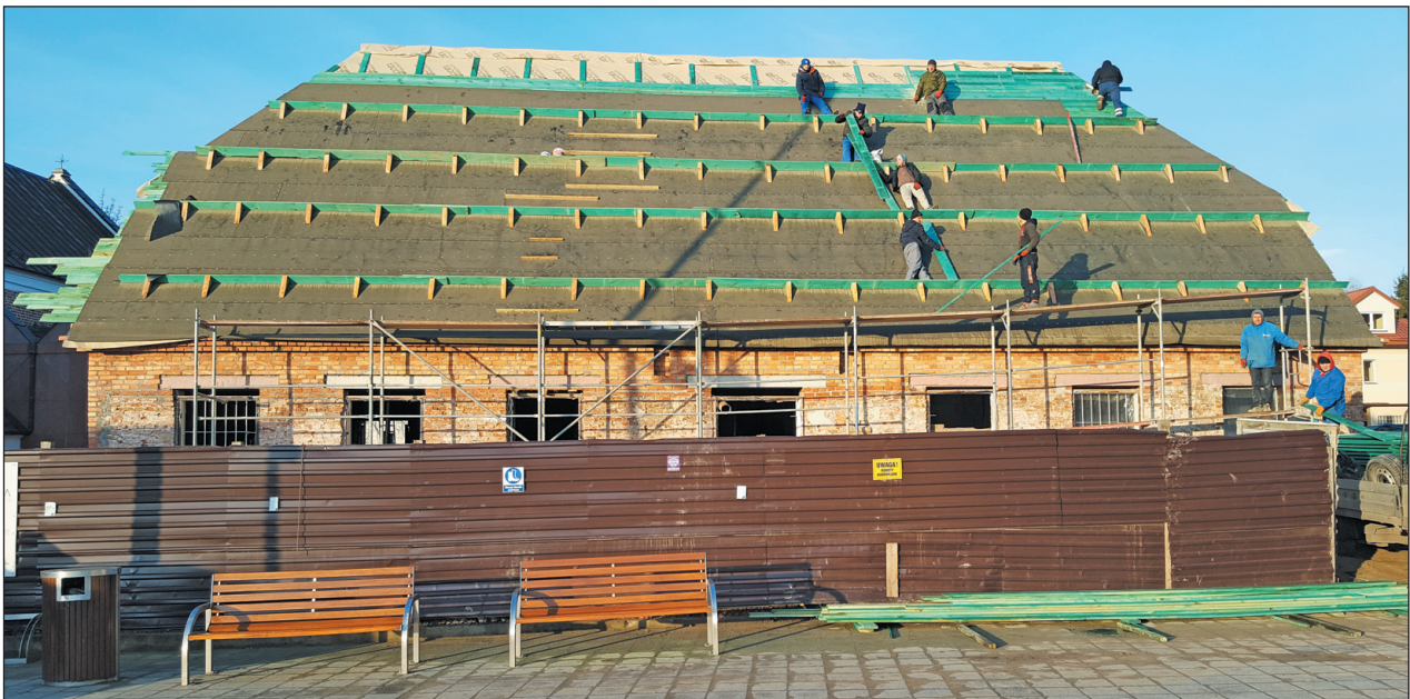
Aktualny widok na remontowaną plebanie
