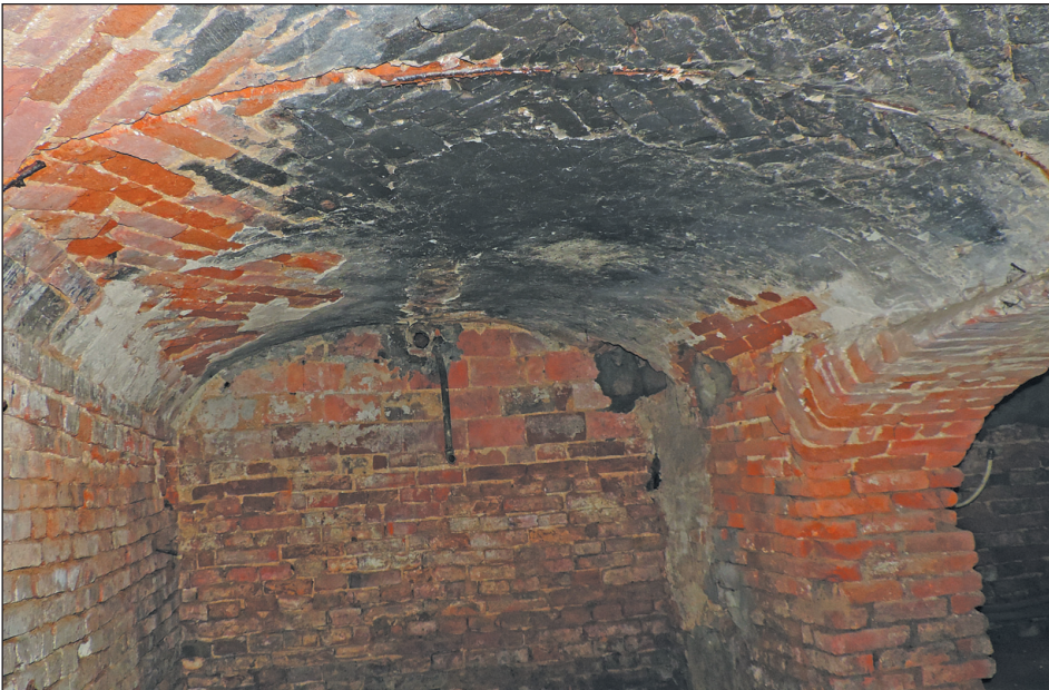
Piwnica Starej Plebanii
