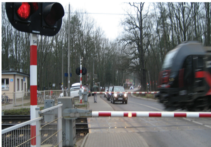
Brak bezpiecznego przejścia na peron w kierunku Warszawy. Fot. L.Ś.
