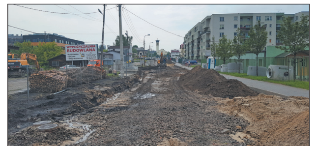
Remontowany fragment ul. Dworcowej
