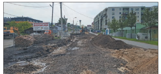
Remontowany fragment ul. Dworcowej
