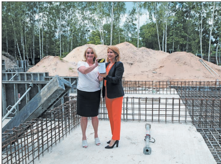
Dyrektor Katarzyna Sobolewska z wiceburmistrzem Hanną Kułakowską-Michalak na placu budowy
