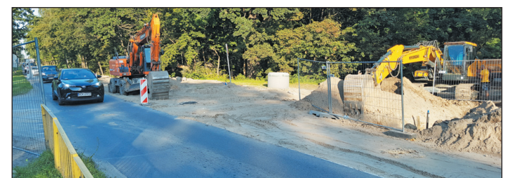
Aktualny stan remontowanego skrzyżowania
