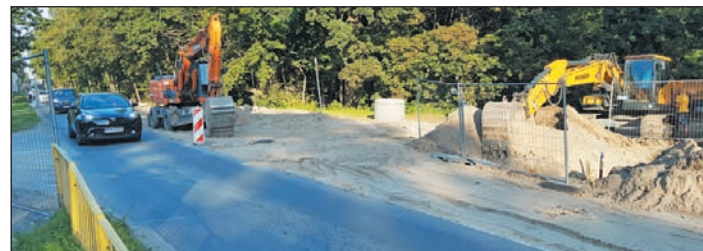
Aktualny stan remontowanego skrzyżowania
