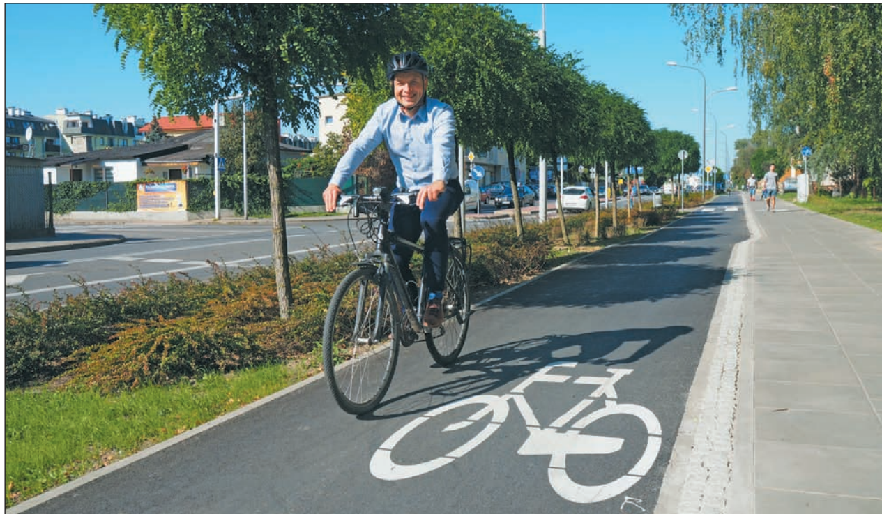
Świeżo oddana do użytku ścieżka rowerowa wzdłuż ul. Powstańców Warszawy
