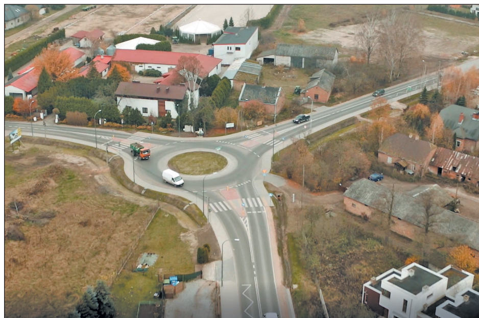
Rondo w Bobrowcu przy ul. Mazowieckiej
