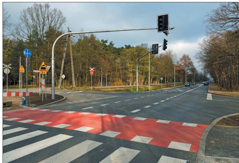
Wyremontowane skrzyżowanie DW 722 alei Polskiego Państwa Podziemnego z aleją Kasztanów oraz aleją 3 Maja w Zalesiu Dolnym
