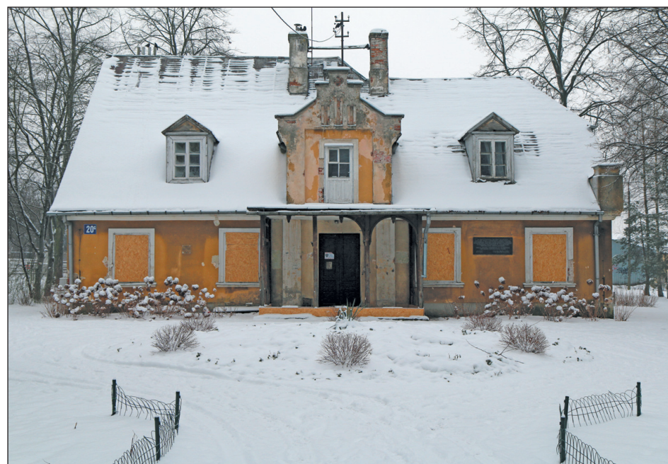
W tym roku rozpocznie się remont zabytkowych obiektów: Poniatówki, Domu Zośki oraz budynku dawnej remizy OSP
