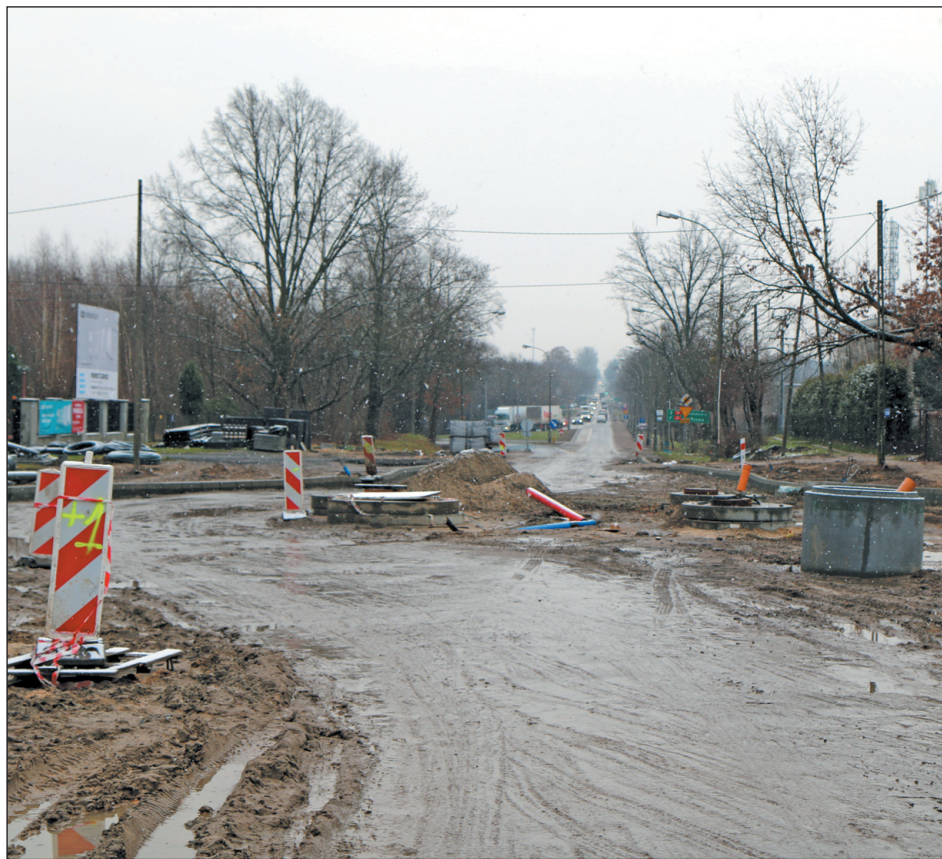
Remontowana ul. Księcia Janusza I Starego – droga wojewódzka łącząca miasto z obwodnicą
