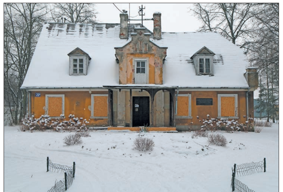
W tym roku rozpocznie się remont zabytkowych obiektów: Poniatówki, Domu Zośki oraz budynku dawnej remizy OSP
