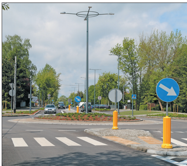
Rondo na wyremontowanej ulicy
