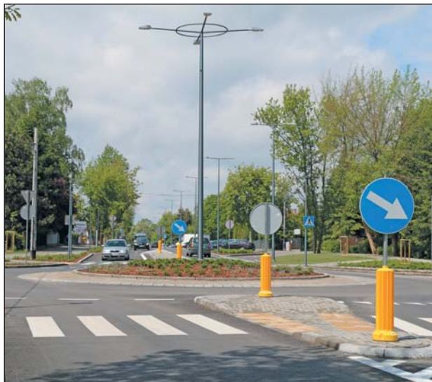
Rondo na wyremontowanej ulicy
