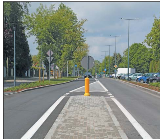
Przebudowana ul. Księcia Janusza I Starego
