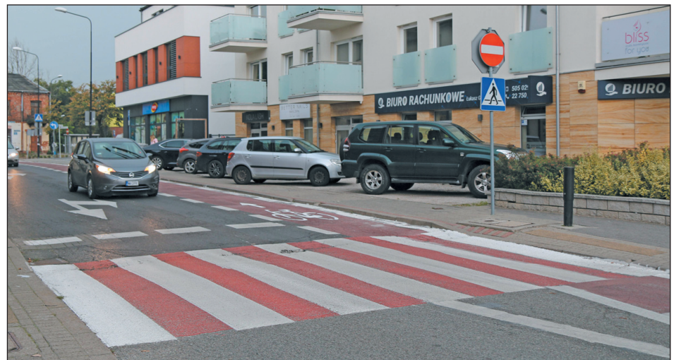
Kontrapas rowerowy na ul. Wschodniej
