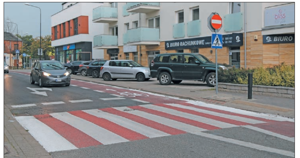
Kontrapas rowerowy na ul. Wschodniej
