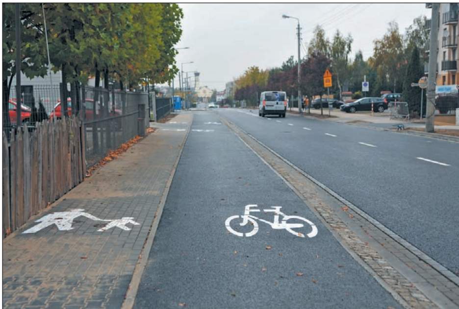
Wyremontowana ulica Dworcowa w Piasecznie
