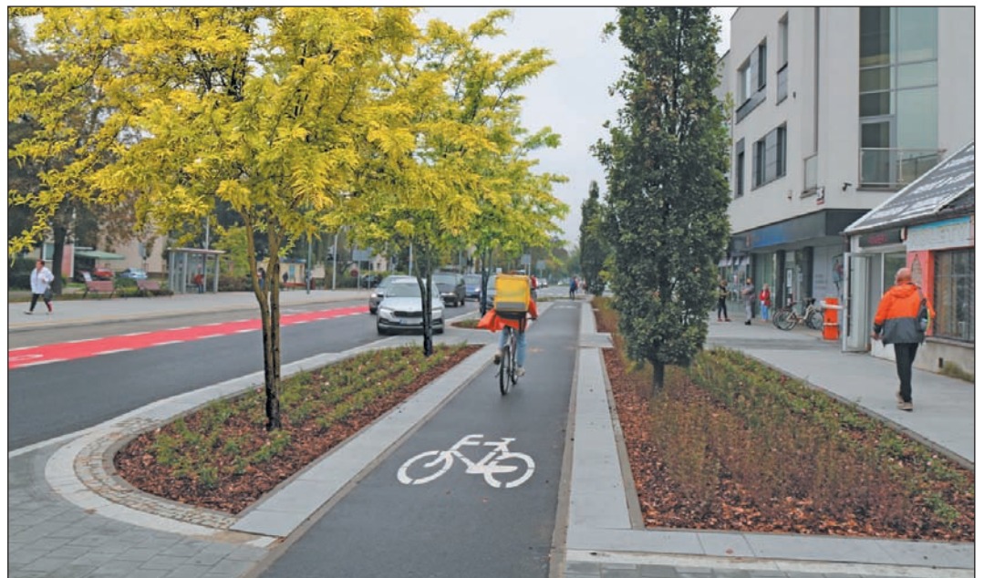
Pierwsze gledicze zostały już posadzone wzdłuż ul. Puławskiej – tak będą wyglądać po rozkwicie
