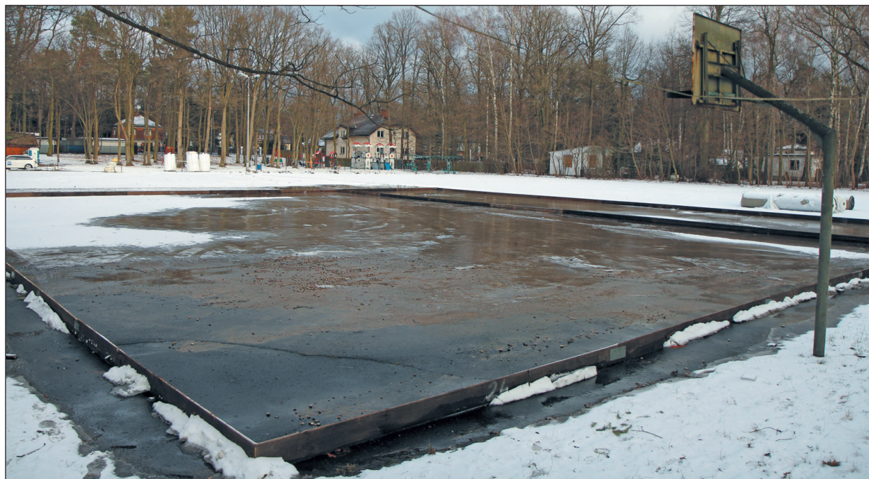
Na terenie sportowym powstanie m.in. boisko piłkarskie ze sztuczną nawierzchnią
