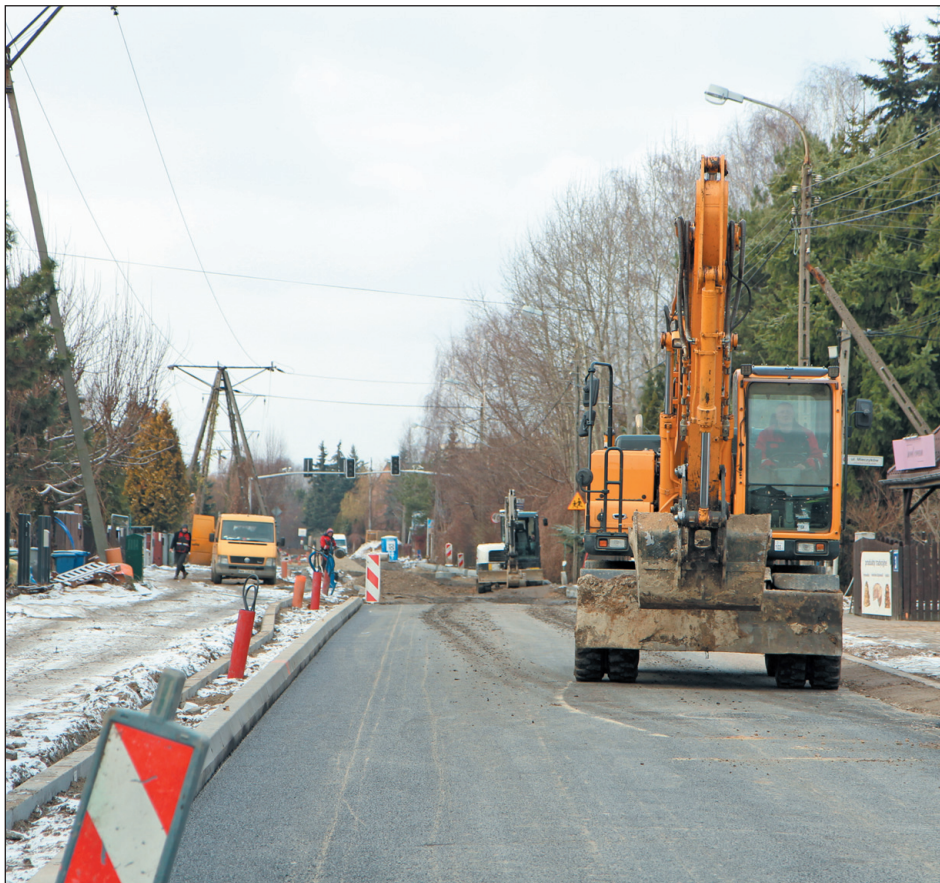
Przebudowa ulicy Geodetów
