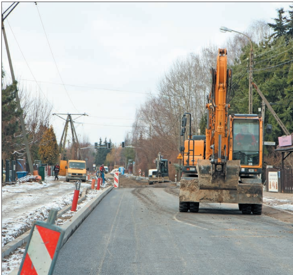
Przebudowa ulicy Geodetów
