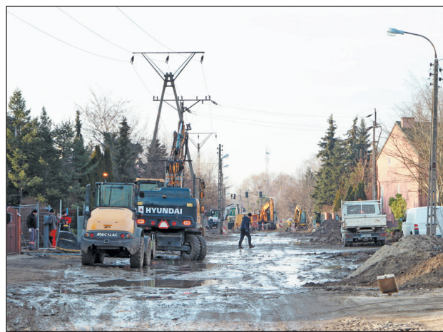
Trwają prace na ulicy Geodetów
