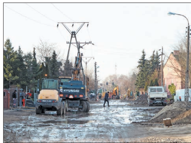
Trwają prace na ulicy Geodetów
