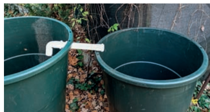
Kaskadowe połączenie zbiorników na wodę
