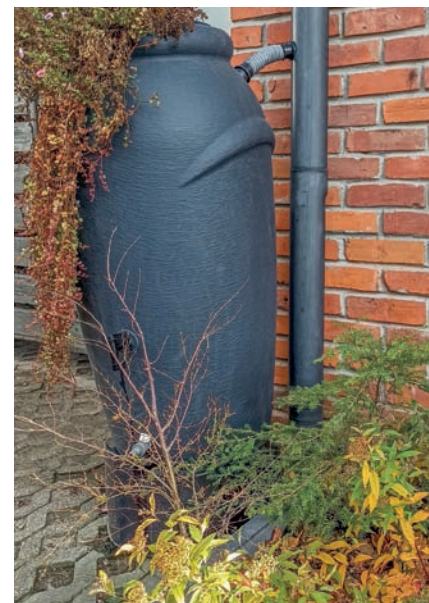
Zbiornik połączony z rynną łapaczem wody
