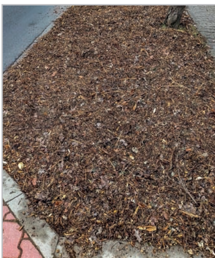
Część pasa drogowego, wypełniona wysokochłoną warstwą zrębków
